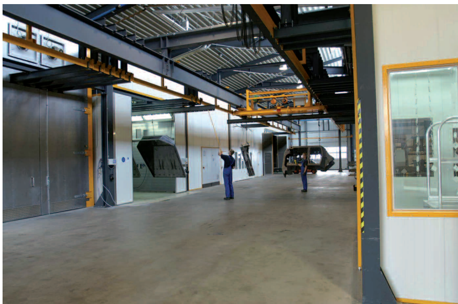
Die Anordnung der Kabinen ähnelt einem „H“. Links: der Einbrennofen, die Waschkabine, das Lacklager, die Nasslackierkabine und die Strahlkabine. Rechts die Pulverkabine. Dahinter befinden sich die Pufferplätze für Warenträger.
