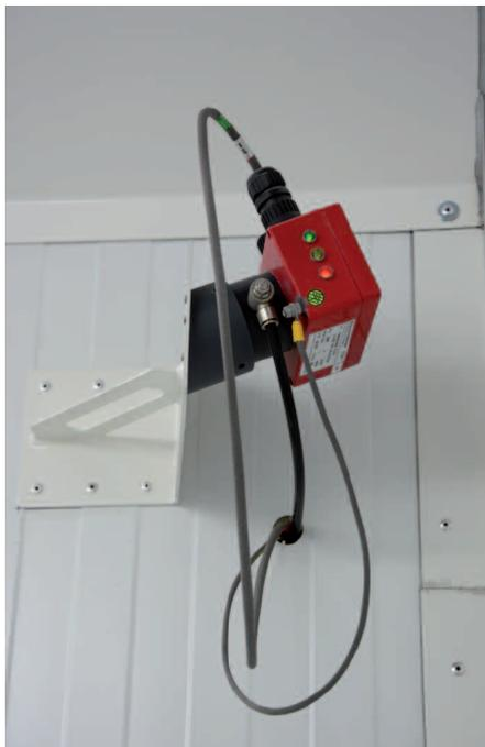
Die Pulverkabine ist mit einer Brandunterdrückungsanlage ausgestattet. Im Fall einer Funkenentwicklung löst die Überwachung u.a. die Löschung mit CO<sub>2</sub> aus.
