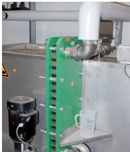
Die Lackieranlage greift, wo es möglich ist, auf die Abwärme der Blockheizkraftwerke zurück - zum Beispiel für den Haftwassertrockner oder die Lackierkabinen. Auch das Vorbehandlungsbad wird über einen Plattenwärmetauscher geheizt.
