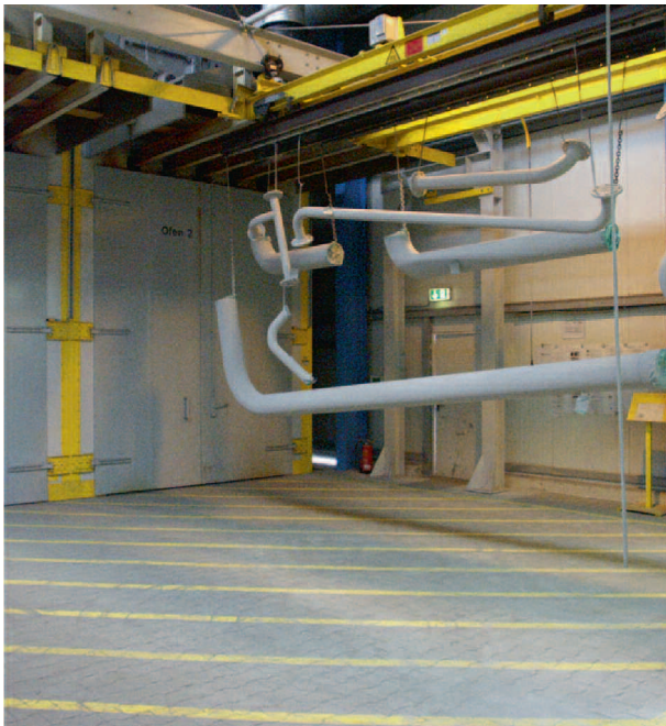
Puffer und Parkplatz zwischen Pulverkabine und Einbrennöfen
