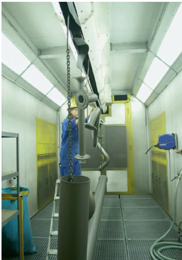
In der Reinigungskabine werden die Werkstücke vom Strahlstaub gereinigt und für die nachfolgende Beschichtung maskiert.
