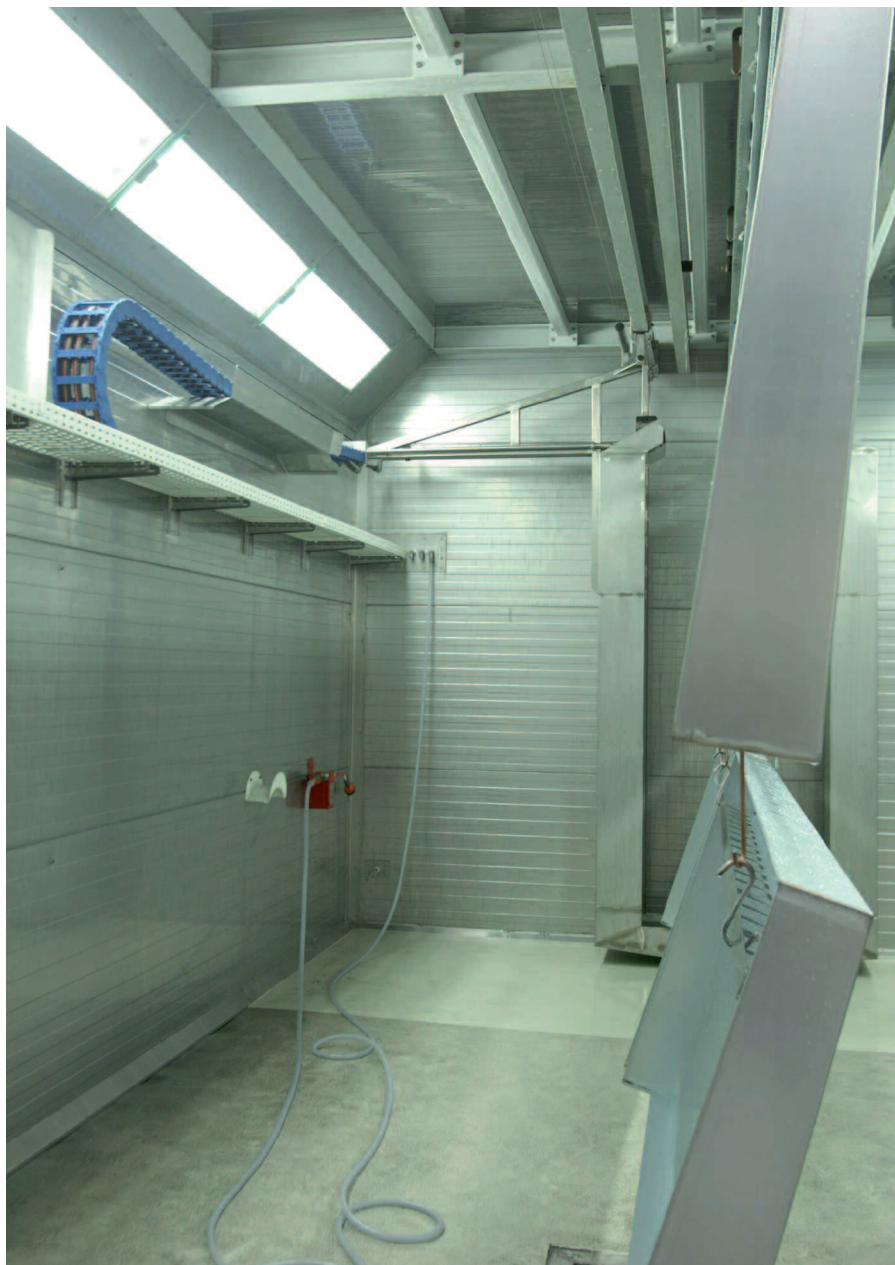
In der Waschkabine für Stahl erfolgt die Vorbehandlung mit handgeführter Sprühlanze.
