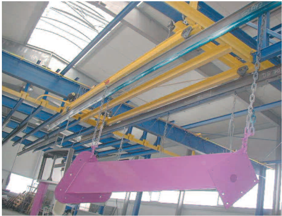
Einfaches Handling, kurze Wege, robuste Technik: Das Transportsystem mit Hebe- und Senkstationen basiert auf handelsüblichen I-Trägern
