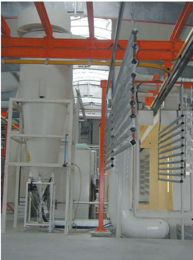
Klein- und Massenteile werden bei LKZ Götzke in einer Durchlaufanlage beschichtet
