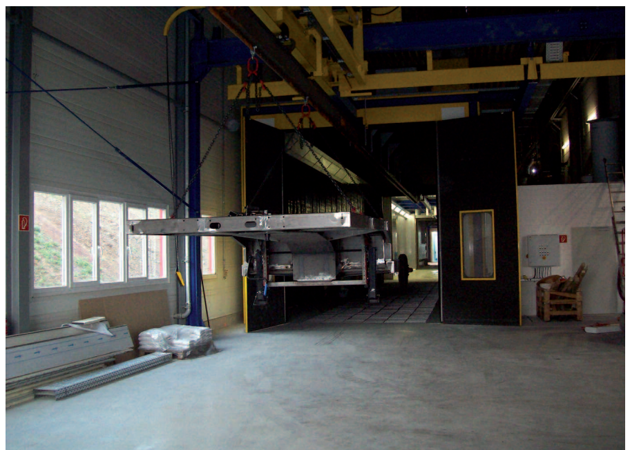
Von der Hub-/Senkstation weg transportiert der Reibradantrieb die Teile durch über 120 m Oberflächenbehandlung.
