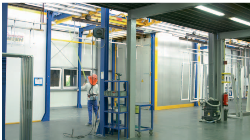
Der Transport der Traversen vor die Pulverkabine erfolgt elektrisch und in die Kabine manuell
